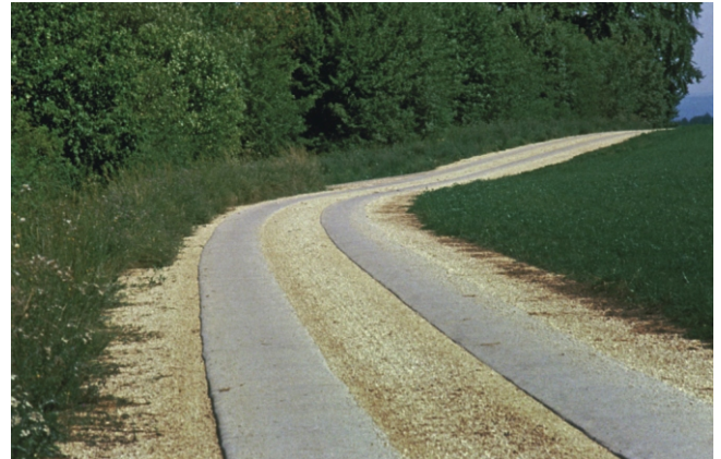
Bild 3: Beton-Spurweg
