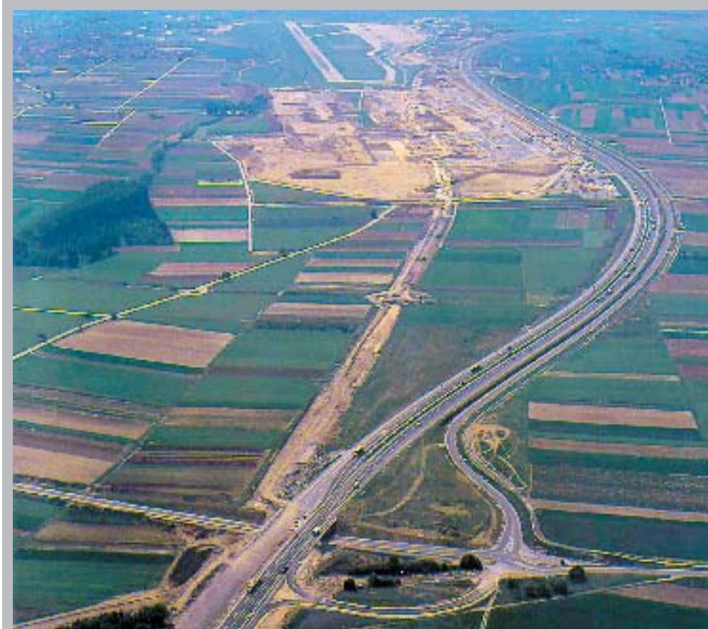
Abb. 19 Autobahn A8, Stuttgart Flughafen
