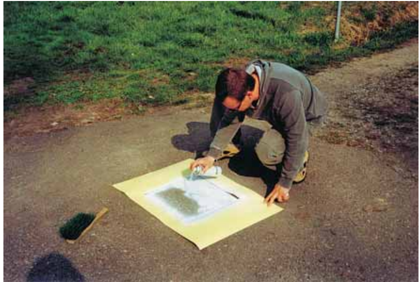
Abb. 2: Der Passpunkt wird mit Farbe markiert
