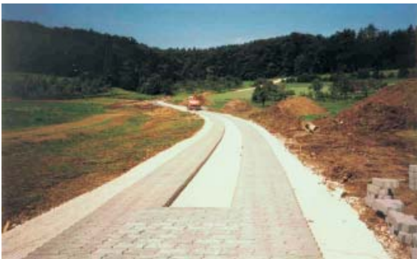
Pflaster fertig verlegt
