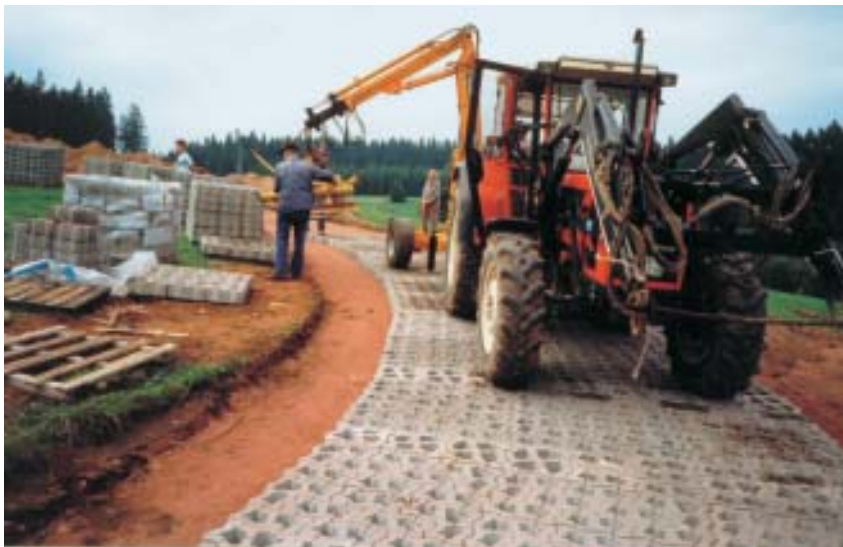
Für enge Kurven gibt es spezielle Pflasterstein-Kurvensätze.
