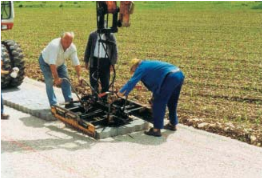
Arbeiten mit der Verlegezange
