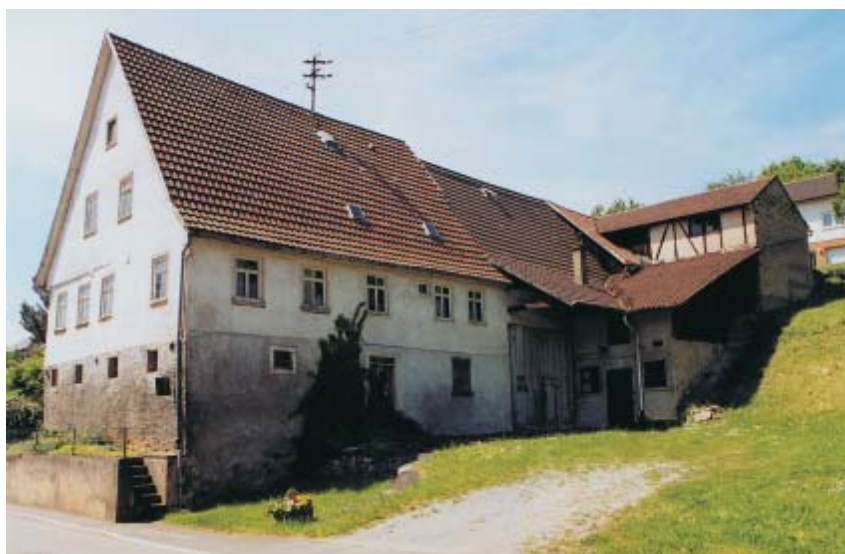
Ein leerstehendes ländlich geprägtes Gebäude
