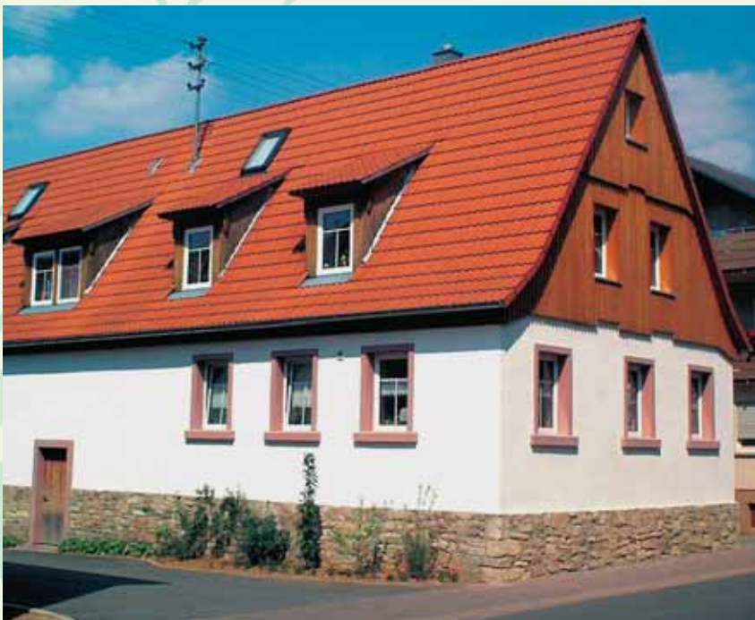
Modernisierung (ehemaliges Förderprogramm Dorfentwicklung)
