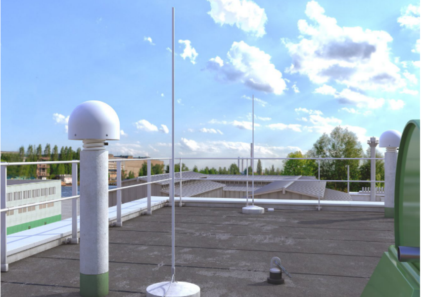
Abb. 9 Referenzstation auf einem Flachdach
