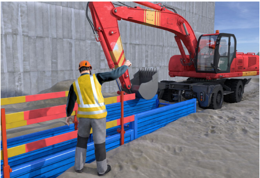
Abb. 21 Grabenverbaugeräte und Absturzsicherung
