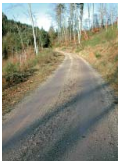
Waldweg nach der Instandsetzung
